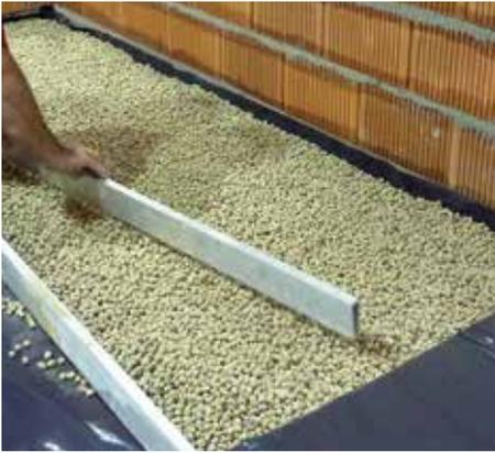
**1** Remblayage et nivellement avec de l'argile expansée Nexclay sèche.
