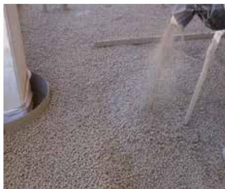
**2** Parallèlement, le liant est mélangé et pompé grâce à une machine appropriée, ce mélange s'effectuant à la sortie du tuyau, grâce à un dispositif approprié.
